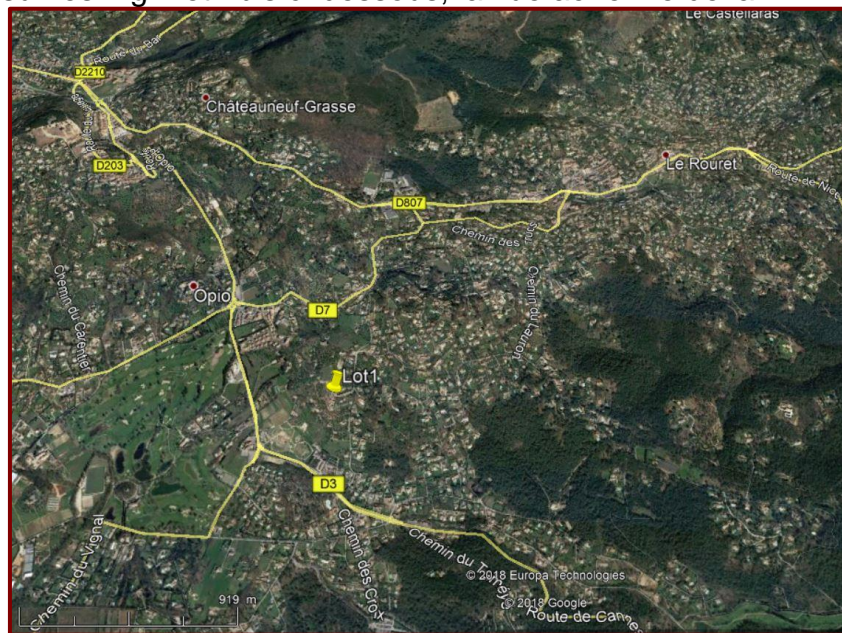
Fig.4 : Vue aérienne du projet. (Source : google earth)
